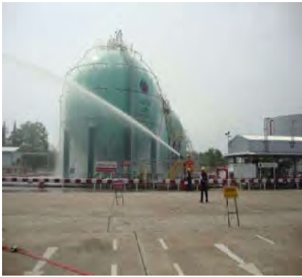
▲ ระบบฉีดน้ำหล่อเย็นถังเก็บก๊าซ (SPHERICAL TANK)
