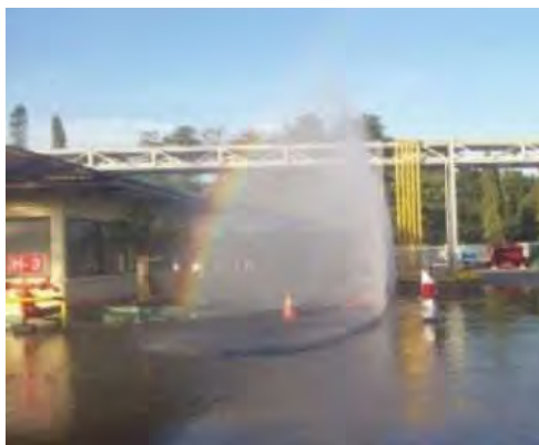
▲ ระบบม่านน้ำหน้าศูนย์ควบคุมปฏิบัติการและบริเวณท่าเทียบเรือ
