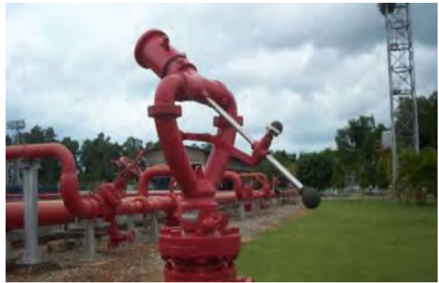
▲ หัวฉีดน้ำดับเพลิงแบบประจำที่ (Fixed Water Monitor) อัตราการฉีด 1,900 ลิตร/นาที จำนวน 8 จุด
